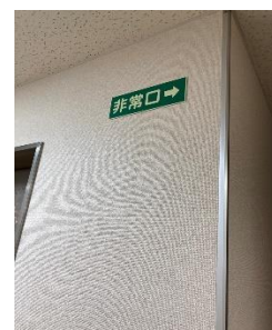
避難誘導蓄光標識設置
